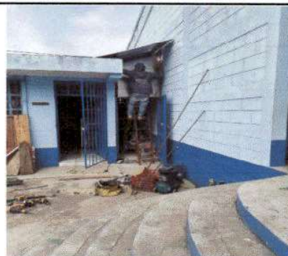
Foto 2: Instalación de la parte de arriba de la puerta de enfrente de la bodega.
