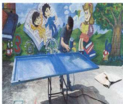
Foto 3: Pintando puerta desinstalada por mantenimiento.
