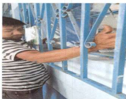
Foto 3: Desinstalación de vidrios quebrados.
