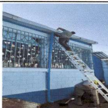
Foto 6: Instalación de canal de aguas pluviales.
