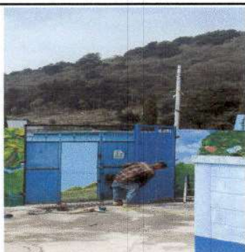
Foto 3: Instalación de las hojas del portón.
