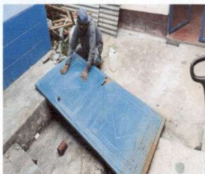
Foto1: Lijando de puertas como parte del mantenimiento.
