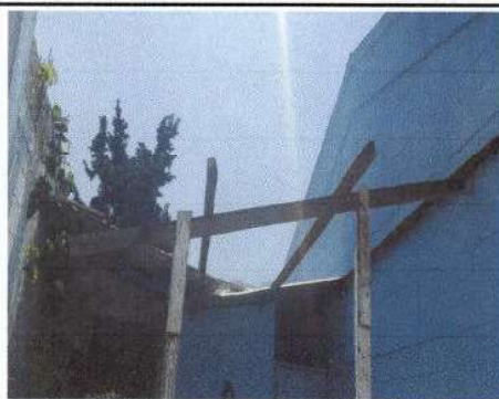
Foto 2: Retiro total de la lámina existente y portantes de madera.
