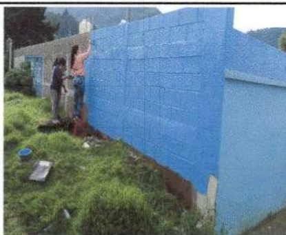
Foto 5: Pintado de parte del muro perimetral parte de atrás en el exterior.
