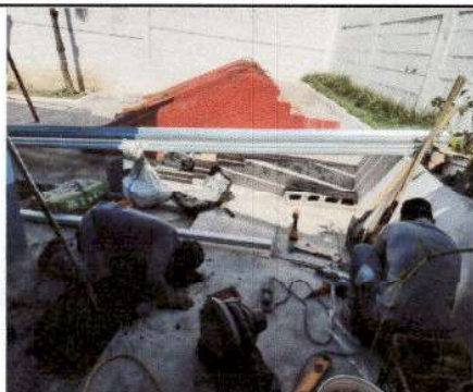
Foto 3: Abertura de orificios para instalar portantes de metal.
