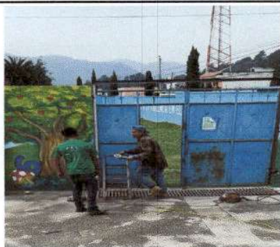
Foto1: Desinstalación de portón de acceso a Estadio Municipal.
