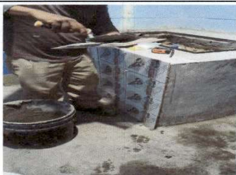
Foto 3: Pegado de azulejo en plancha.
