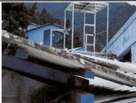
Foto1: Instalación de la base del rotoplas.
