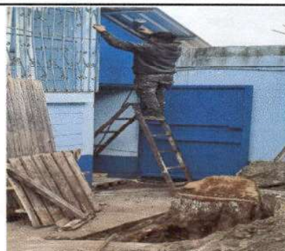
Foto 4: Instalación de la puerta trcera de la bodega.
