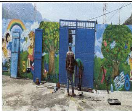
Foto 4: Instalación de las palancas para sujetar el portón al piso.
