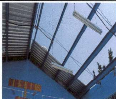
Foto 5: Inicio de la instalar de lámina.
