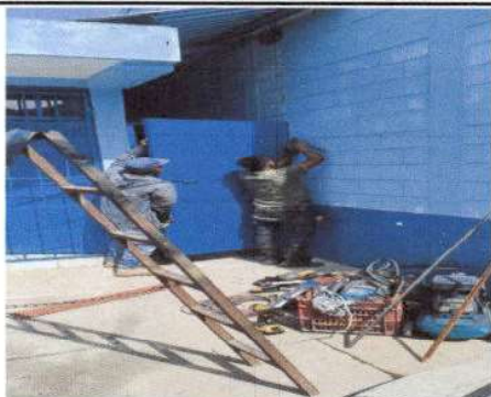
Foto1: Instalación de la puerta de enfrente de la bodega.
