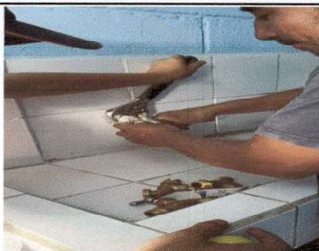
Foto1: Desinstalación de chorros.
