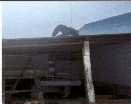
Foto1: Retiro de lámina del techo del área de pila.
