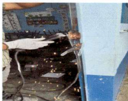
Foto 6: Instalación de chapas.
