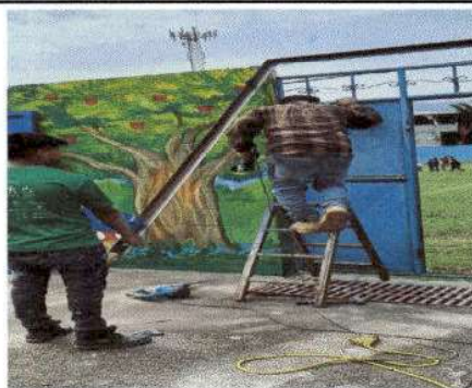
Foto 2: Instalación del marco del portón y sujeción a la pared.
