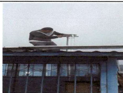
Foto 6: Instalación de sombrero de chimenea de metal.
