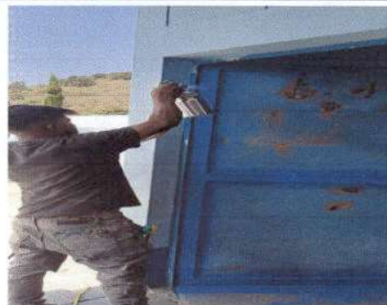
Foto 4: Pintando puertas en su lugar por no poder desinstalarlas.
