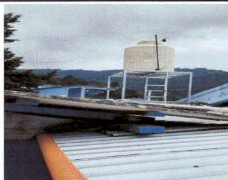
Foto 2: Instalación del Rotoplas.
