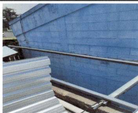
Foto 2: Instalación de portantes de metal.
