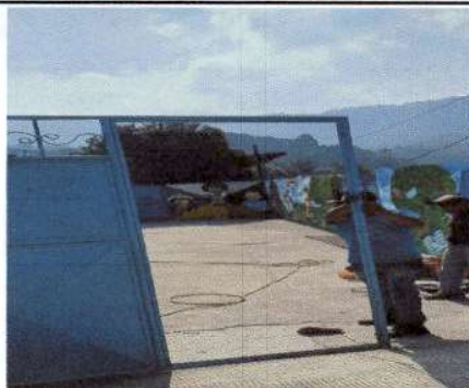
Foto1: Retiro de la fijación del portón de ingreso principal.
