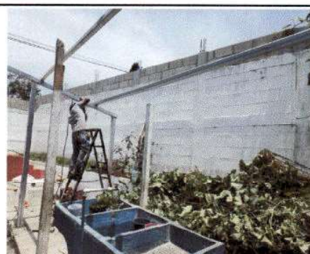
Foto 4: Instalación de portantes de metal.
