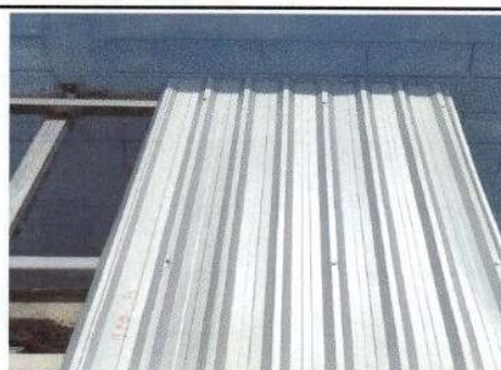
Foto 6: Instalación de lámina.
