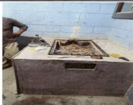
Foto 2: Instalación marco sujetador de plancha.
