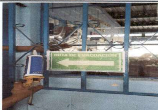
Foto 4: Instalación de Vidrios.
