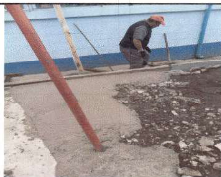
Foto 5: Vertimiento de material (mescla) en el área de sustitución de losa.
