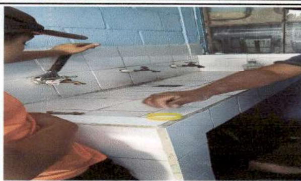
Foto 2: Instalación de chorros.
