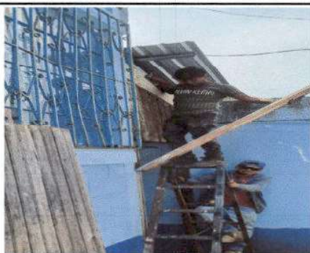
Foto 3: Desinstalación de la puerta trcera de la bodega.
