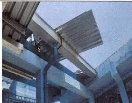
Foto 4: Subir materiales a utilizar (lámina alizinc calibre 26).
