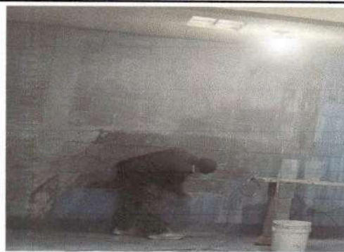
Foto 2: Reacomodo de pared para la aplicación de repello.
