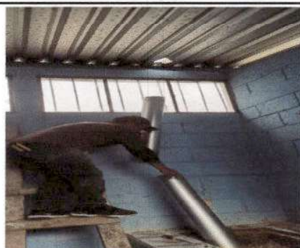
Foto 5: Instalación de chimenea.
