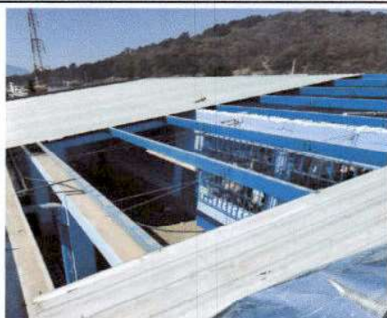
Foto 3: Área lista para trabajar la instalación de lámina.
