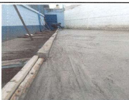
Foto 6: Tallando y acabados del área de entortado.
