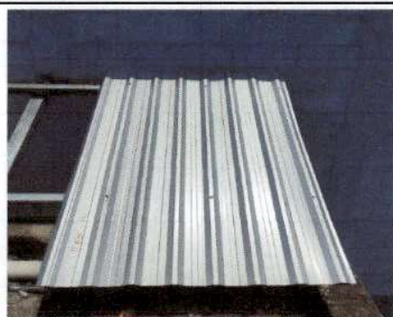
Foto 3: Instalación de lámina de la bodega.
