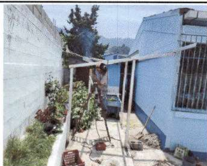
Foto 5: Sujetando portantes con soldadura.
