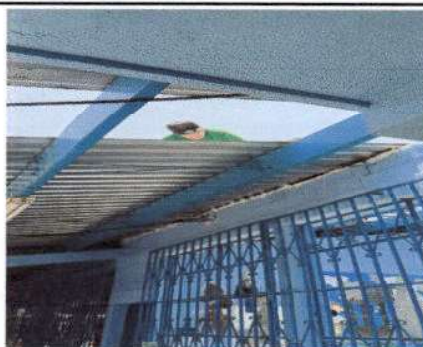
Foto 6: Instalación de lámina.
