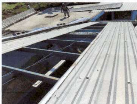
Foto 1: Retiro de lámina del techo del aula, lámina por lámina.
