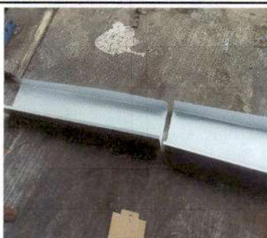
Foto 5: Fabricación de canales para aguas pluviales.
