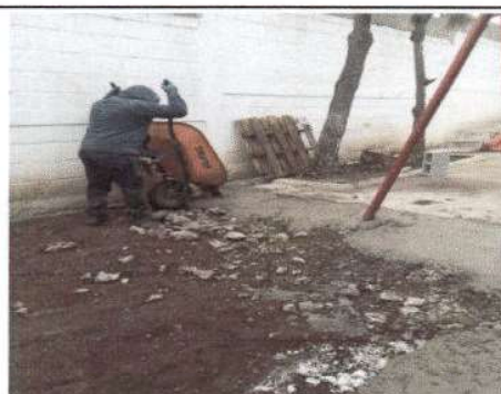
Foto 4: Inicio de entortado del área de los resvaladeros.
