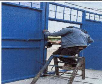
Foto 5: Soldadondo palanca para sujetar portón.
