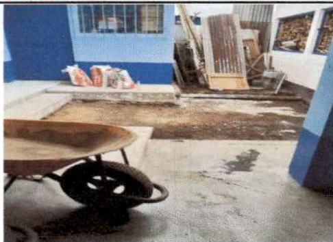
Foto 1: Retiro de losa con daños y preparación para el nuevo entortado.
