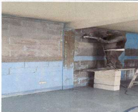
Foto 1: Retiro de pintura en paredes.
