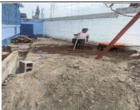
Foto 3: Arrancado de árboles, quitado de losa dañada y preparación del área.
