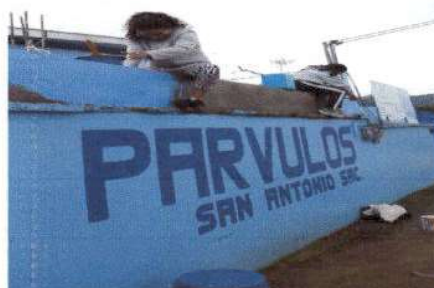
Foto 4: Pintado de la parte superior del muro o pared perimetral del Establecimiento Educativo parte de afuera .
